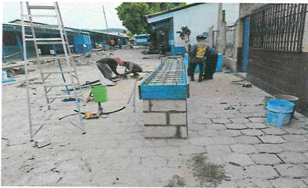
Foto 3: Reparación e instalación de servidor de alimentos.
