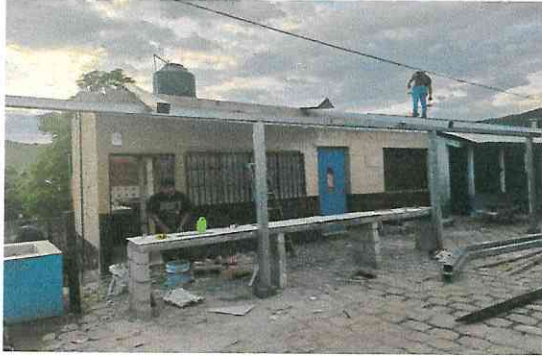
Foto 1: Demolición e instalación de cubierta de techo de cocina y bases y techo de galera de área de pila y servidor de alimentos.
