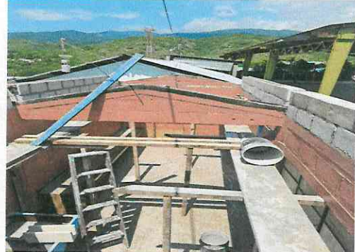
Foto 2: Levantado de paredes en área de la cocina.
