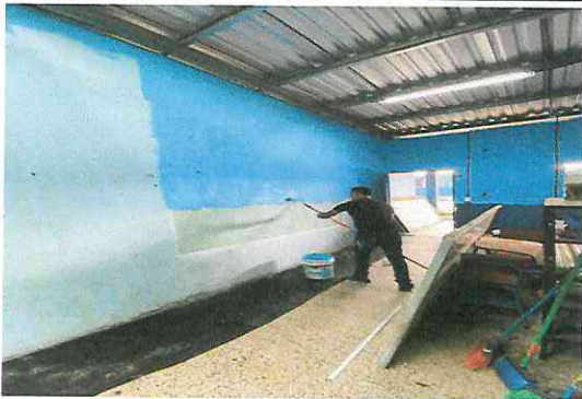
Foto 5: Sustitución de pintura interior y exterior
