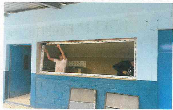
Foto 4: Sustitución de ventanales por ventanas de PVC.
